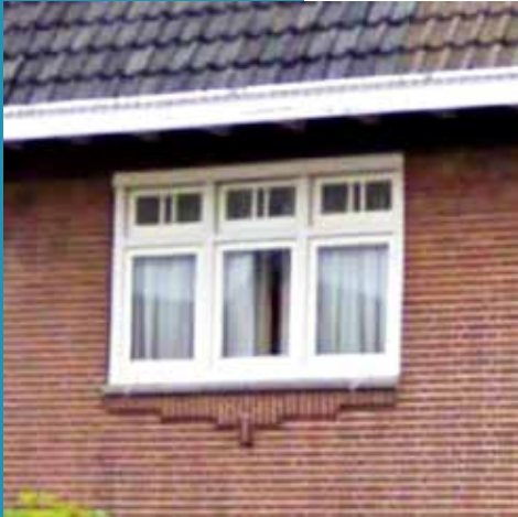
Kozijn en metselwerk werken samen
