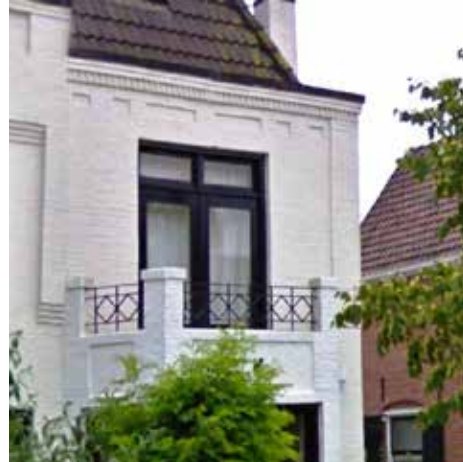
Karakteristieke plasticiteit in het metselwerk
