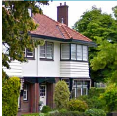
Kozijnen en houten delen zijn beide horizontaal
